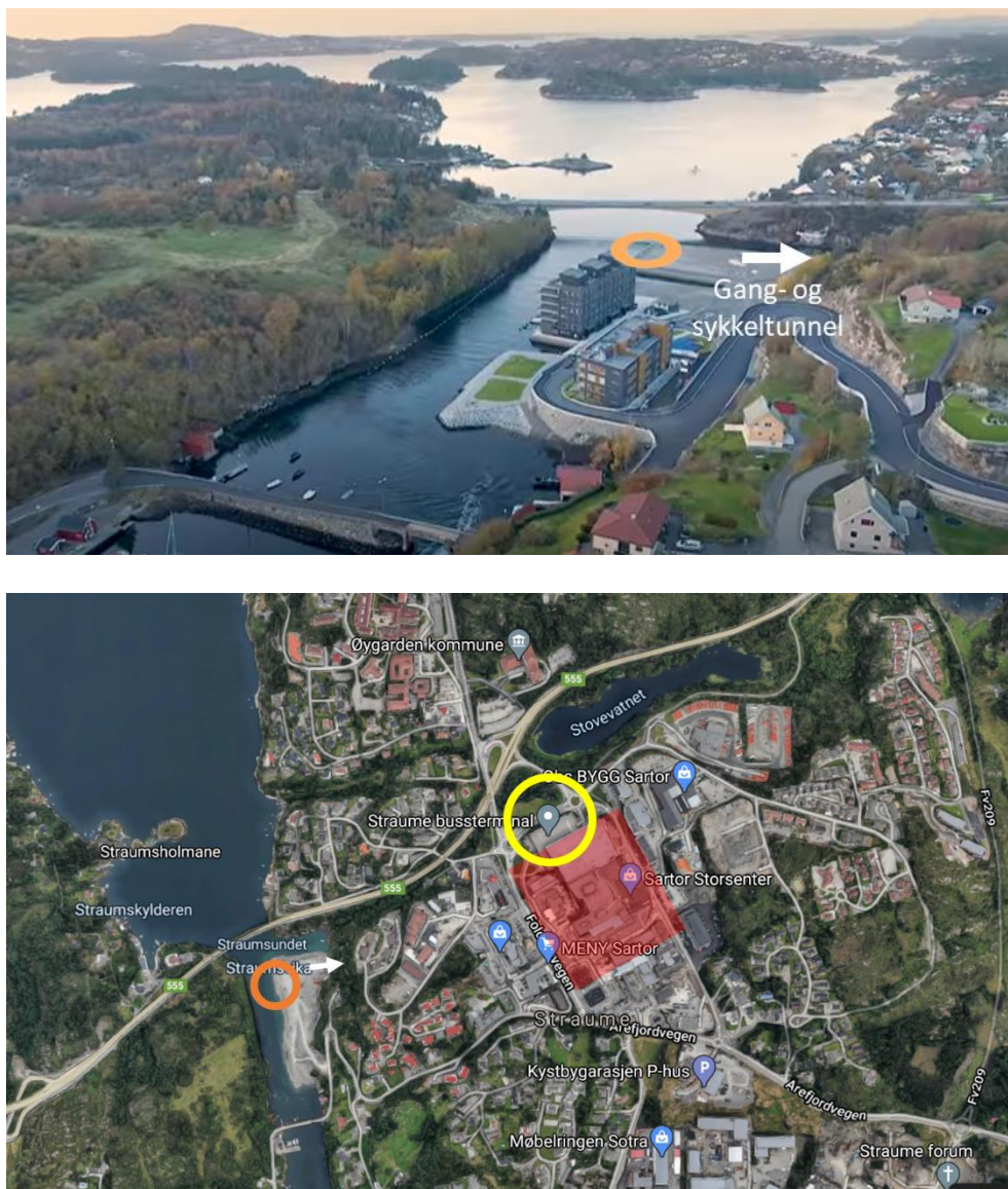
Figur 5-2 Forslag til kaiplassering ved Straume Sjøfront. Øverst et bilde som viser lokaliseringen av den nye gang- og sykkel tunnel (hvit pil). Den ender ved Sartor Storsenter ca. 500 m mot øst. Nederst en figur som viser mulig plassering (oransje) av kaien i forhold til Straume Terminal for busser (gul) og offentlige parkeringsplasser i området (rød)
